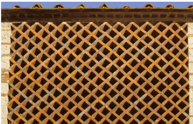
fig. 15 Claustra de fenil en échiquier diagonal : le motif renvoie à l'opus reticulatum romain (Meleto, Gaiole in Chianti). Photo : I. Agostini e D. Vannetiello.
