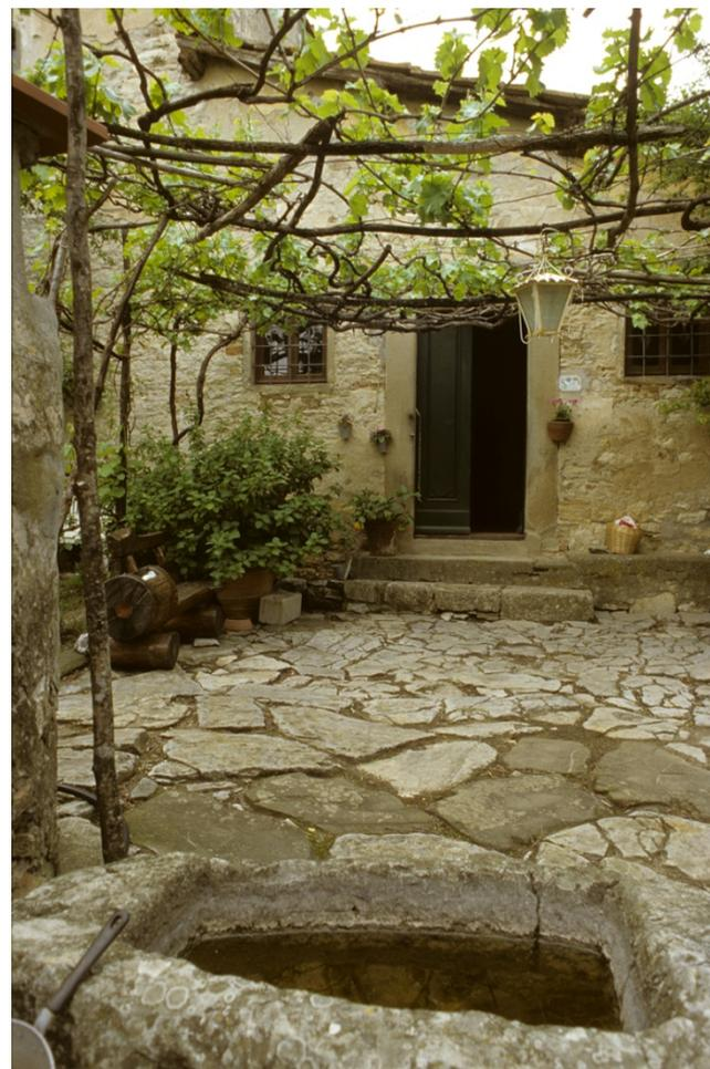
fig. 16 Aire pavée en pierre calcaire à opus incertum (Ciarlico, Calenzano). Photo : I. Agostini e D. Vannetiello.
