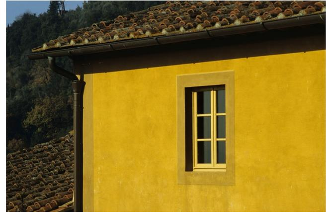
fig. 12 Enduit et fenêtre restaurés à l'identique dans une maison rurale près de Fiesole (arch. R. Budini Gattai). Photo : I. Agostini e D. Vannetiello.
