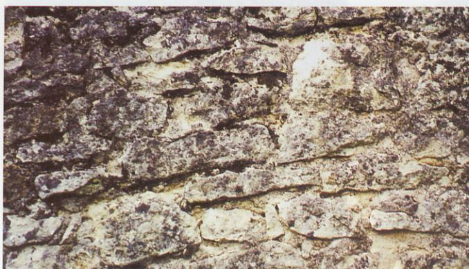
*Mur de soutènement en moellon. Mortier de sable clair très riche en calcaire.*
